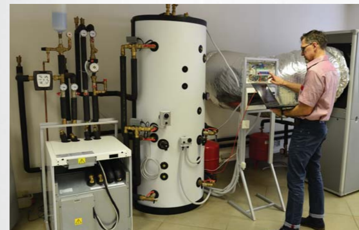
Próby ciśnieniowe zbiorników akumulacyjnych
