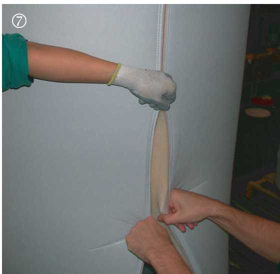
Obrázky znázorňujúce postup montáže izolácie s PVC fóliou na nádrž.
