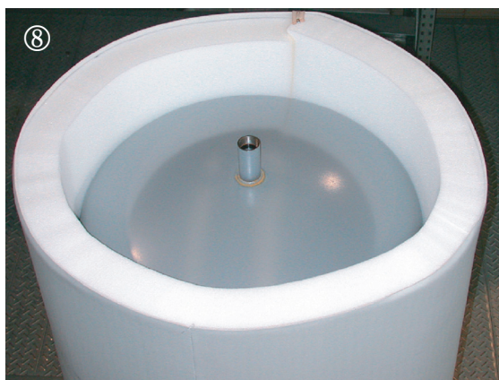
Obrázky znázorňujúce postup montáže izolácie s PVC fóliou na nádrž.
