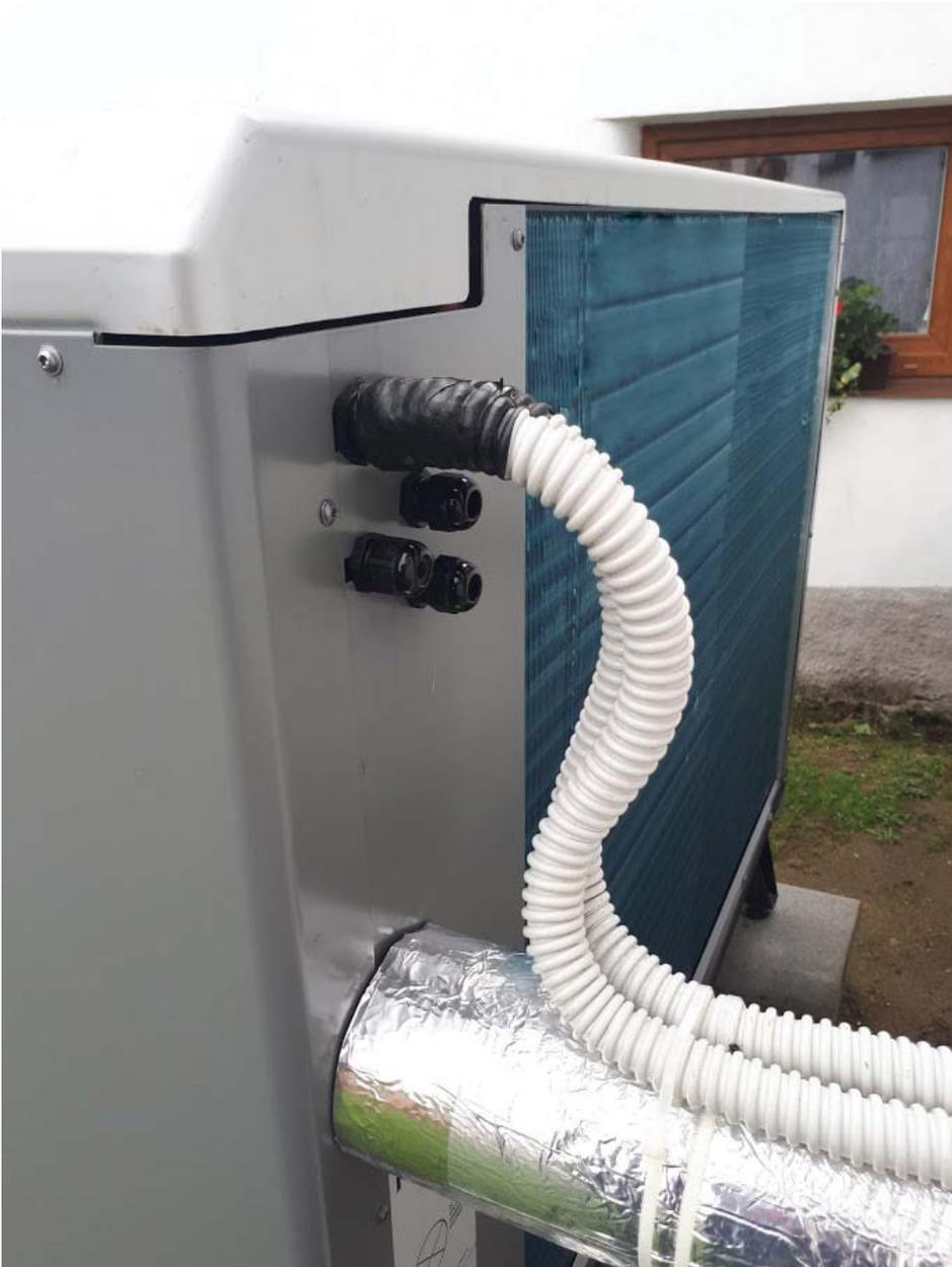
\* Für den Anschluss des Verlängerungskabels empfehlen wir die Installation einer Anschlussdose oder eines Schalters (in einigen EU-Ländern vorgeschrieben) in der Nähe der Wärmepumpe.
