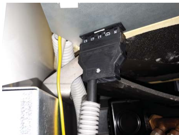
Připojení do konektoru X10 - pohled zdola.
