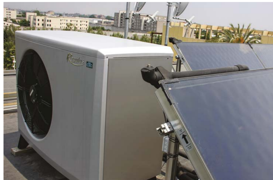
Instalace solárních kolektorů a tepelného čerpadla na střeše pavilonu
