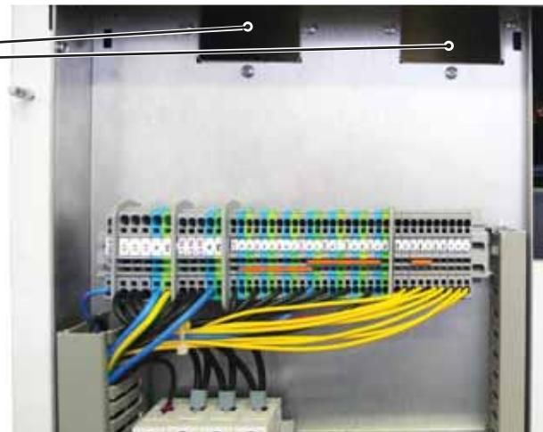
Při pripojování maximálního průřezu slaněného vodiče do přípojně svorkovnice nedoporučujeme používání dutinek. Na vodiče s menším průřezem (typicky čidla, PWM a pod.) jsou dutinky vhodné. Minimální délka odizolování 9 mm.
